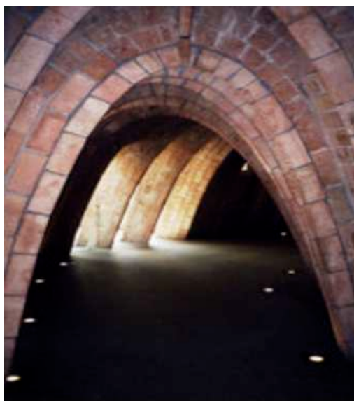
Figura 4.56: Arco Catenário da casa de Milá. A catenária invertida é uma estrutura que se auto sustenta. Disponível em Torres (2014)
