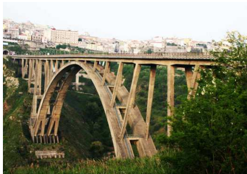
Figura 4.57: Ponte Bisantis, Itália. Conhecida pelo nome do engenheiro que a projetou: Viaduto Morandis. Disponível em Morandis .
